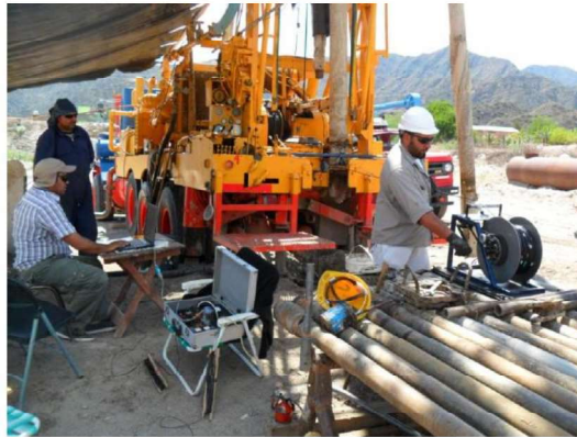
Foto 2: Realización del perfilaje eléctrico computarizado.
