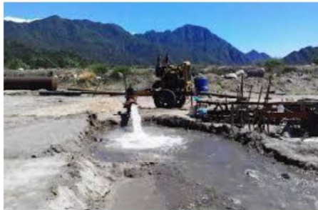
Foto 3: Desarrollo por bombeo con bomba de eje vertical.
